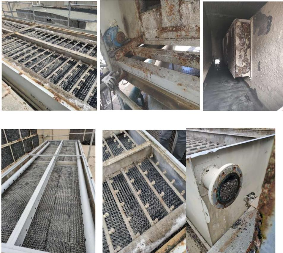
Le torri evaporative sono a servizio del raffreddamento dei condensatori dei gruppi frigoriferi esistenti per il condizionamento del terminal A.
